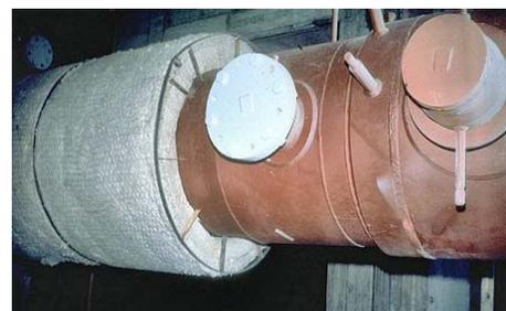
Рис. 8. Каркасное кольцо для покровного слоя трубопровода
